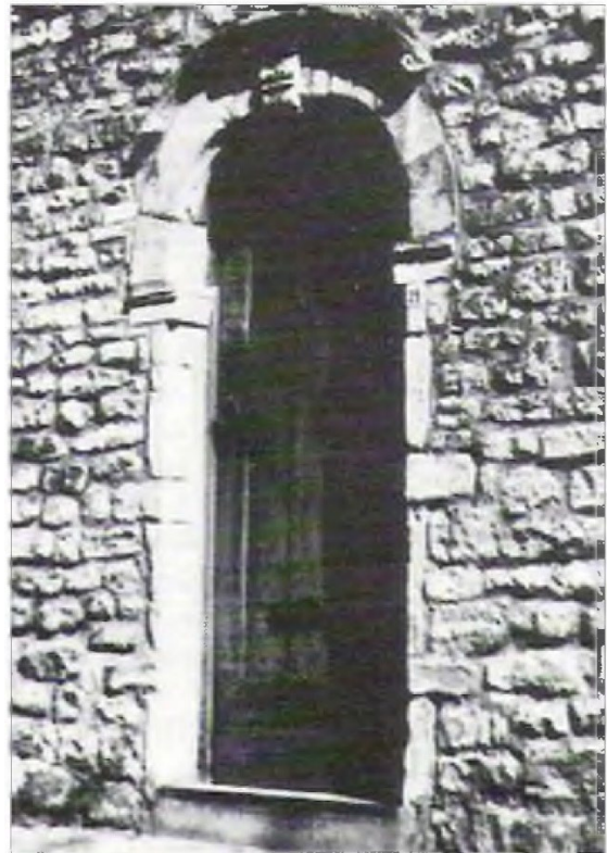
Deuromlijsting in zandsteen
