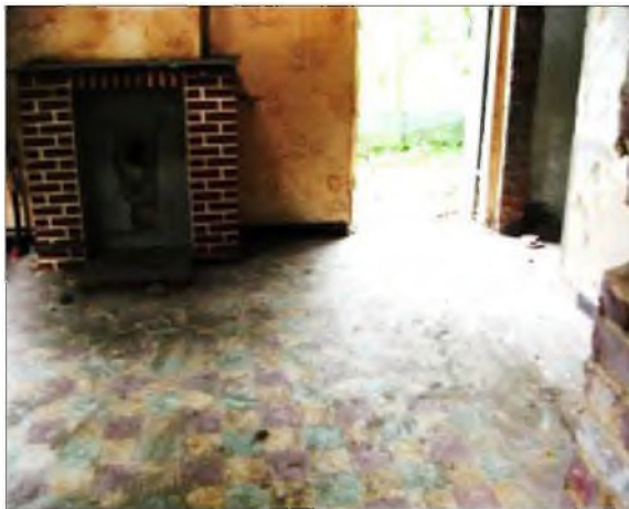
Beeld van de woonkamer (vlak voor de afbraak), met schouw en vloertegels (foto Dirk Taekels).
